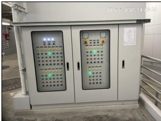
ภาพที่ 21 ระบบมิเตอร์ไฟฟ้าสำหรับระบบบำบัดน้ำเสีย
