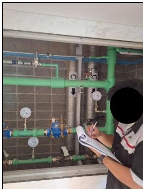
ภาพที่ 51 (ต่อ) เจ้าหน้าที่ตรวจสอบระบบจ่ายน้ำประปาและเส้นท่อ
